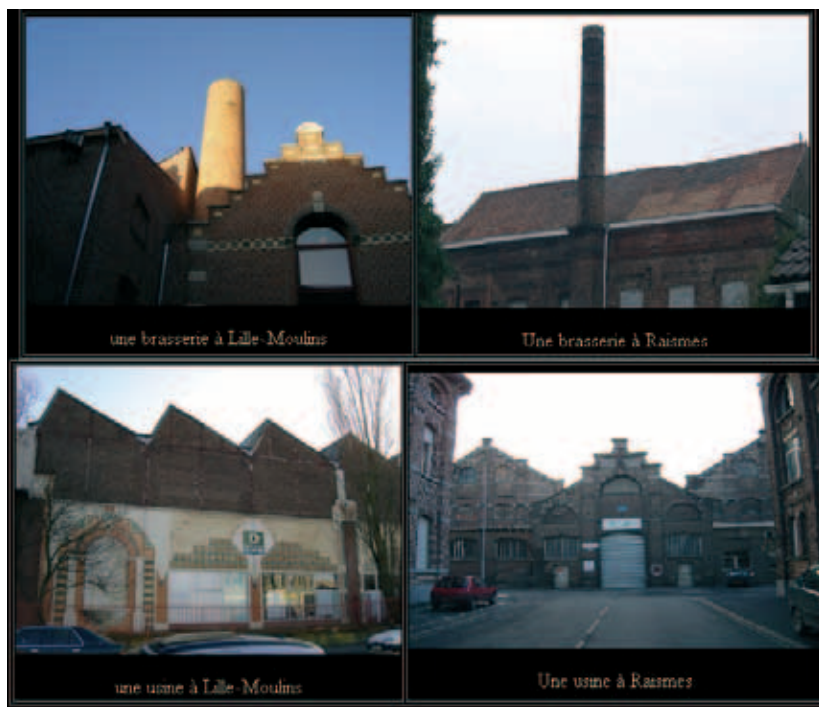
Les usines, des bâtiments patrimoniaux http://cjouneau1.free.fr/hyperpaysage/raismes1.htm#metal
